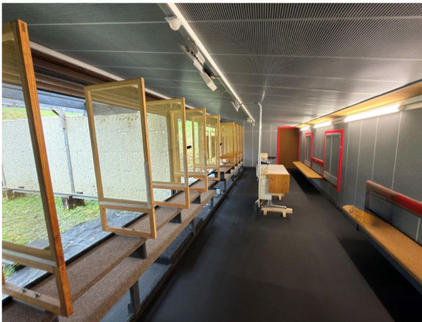
Der Schiessraum wurde mit einem neuen Schallschutz ausgestattet und entsprechend verkleidet.
