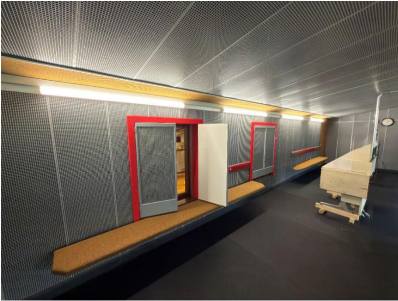
Der Schiessraum ist an Boden, Wänden und Decke komplett mit Lärmschutzmaterialien ausgestattet. Eine spezielle lärmschützende Fensterzone trennt den Schiessraum von der Schützenstube.
